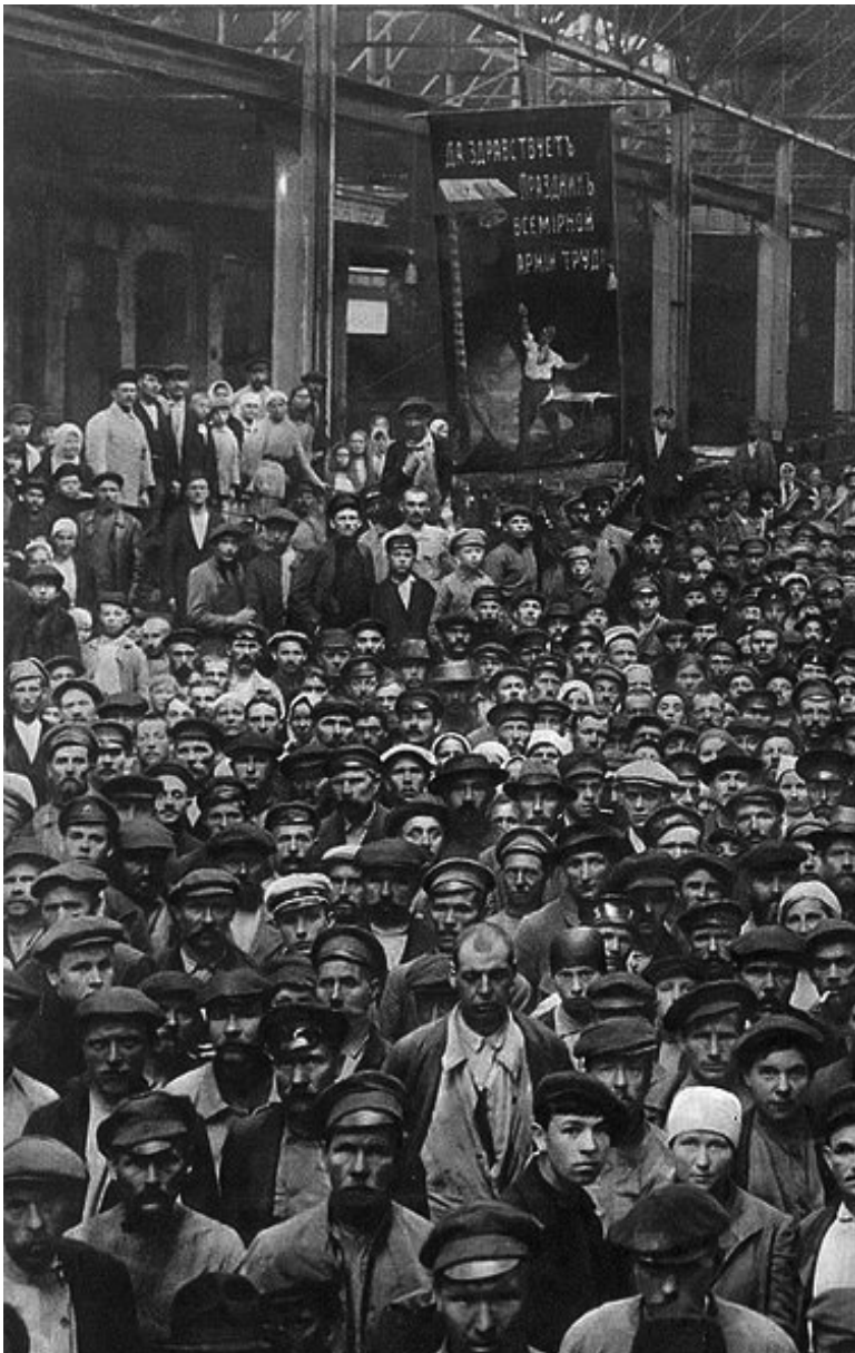
Obreros de la fábrica Putilov
